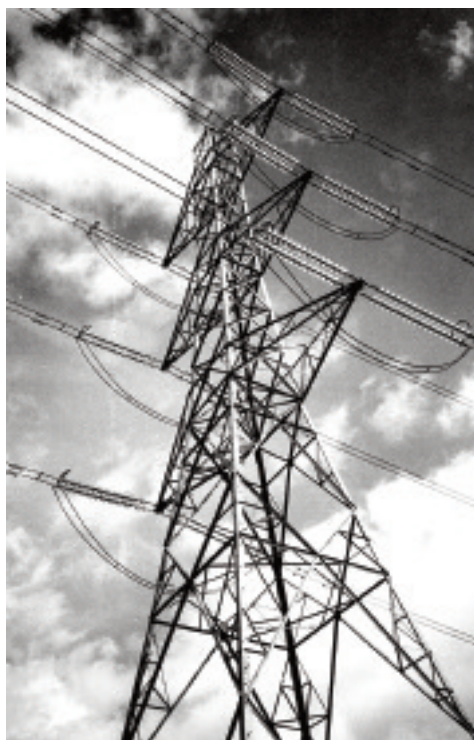
A 400kv pylon
